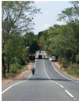
工事が進む幹線道路
