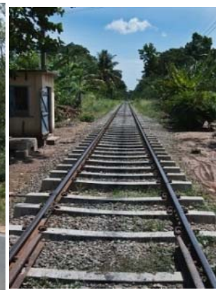
復旧が進む鉄道
