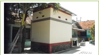
機器を設置するための建物
