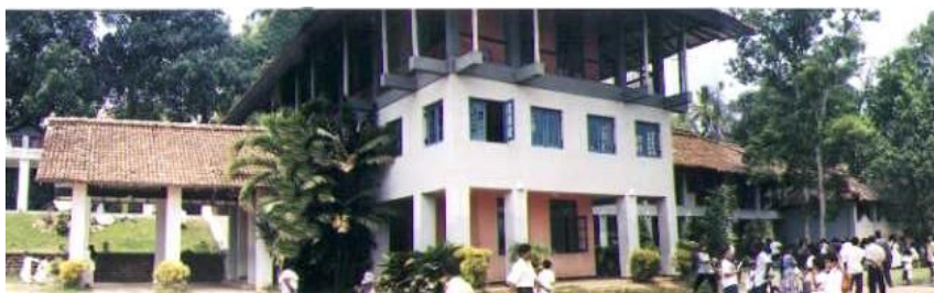
1993年に竣工したC.P.I.とSNECCとの共同施設はさらに充実している
